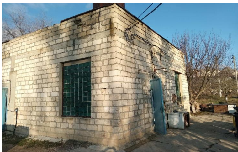
Figura 33 Stația de pompare
