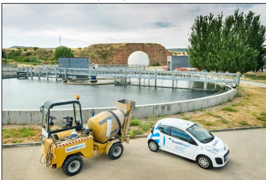
Figura 9 Instalaciones de la EDAR de Guadalajara
