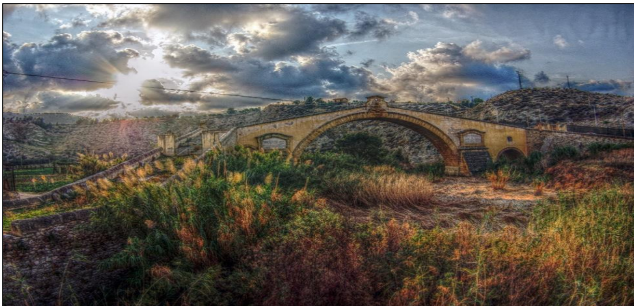
Figura 2.7.5– Ponte di San Leonardo
