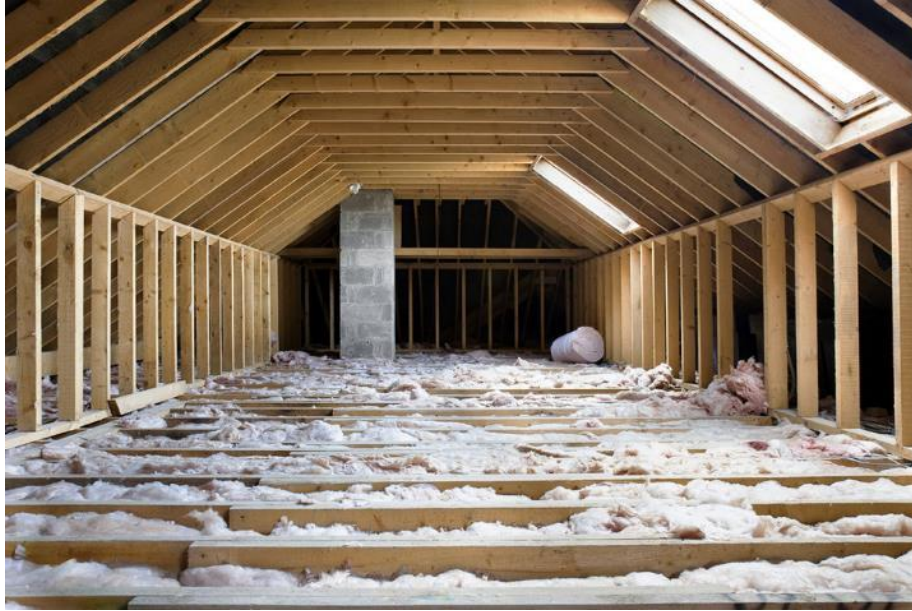
Figure 28 Izolarea termică a tavanelor
