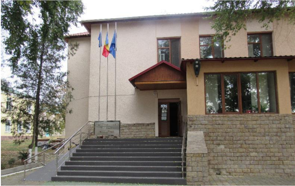
Figure 25. Clădirea primăriei din sat
