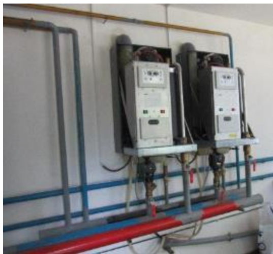
Figure 34 Centrala pe gaz natural a școlii din Văleni
