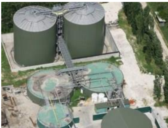
Fig. 39 Impianto di digestione anaerobica SESA (Fonte. http://www.sesaeste.it/ ).
