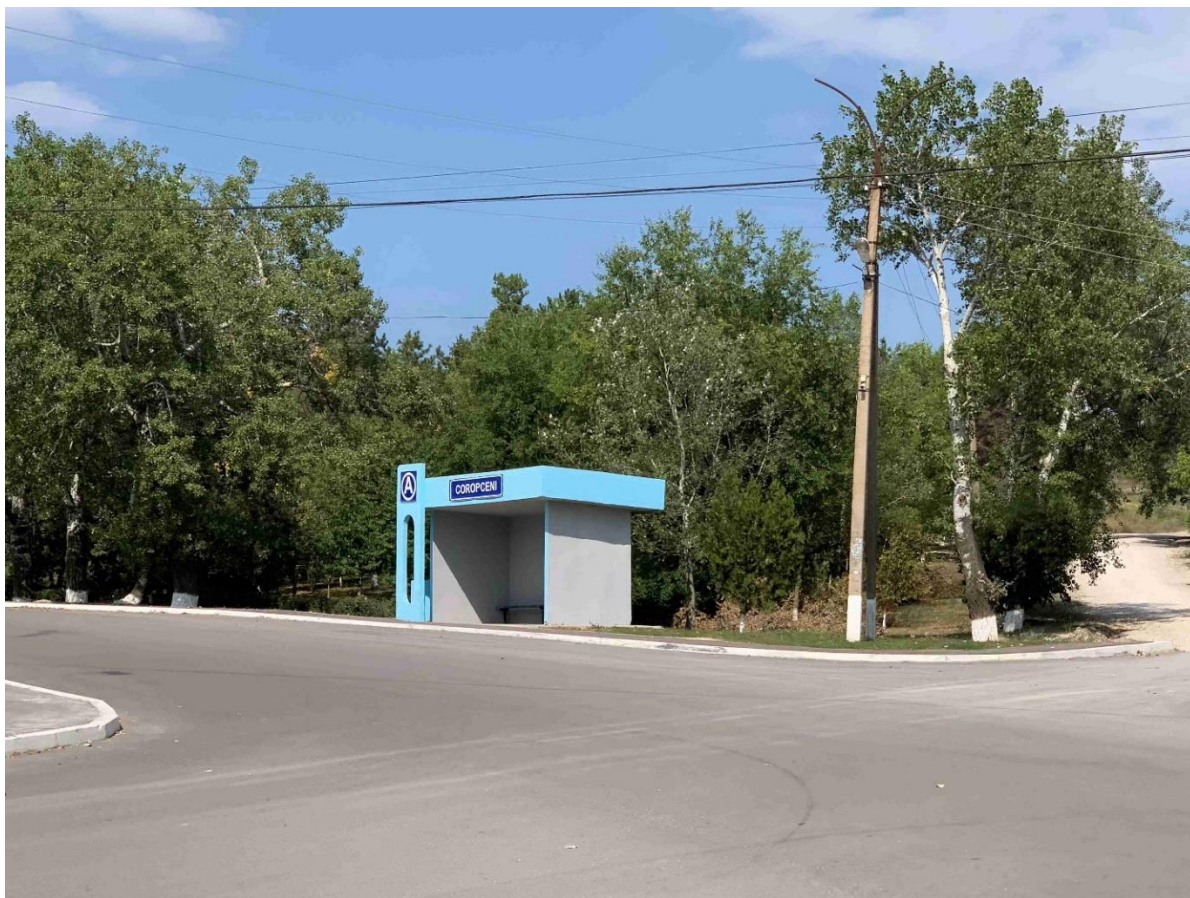
Figura 5 – Stația de așteptare în satul Coropcenii
