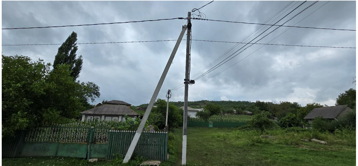
Figura 3. Iluminat public cu corpuri de iluminat LED în satul Călinești
