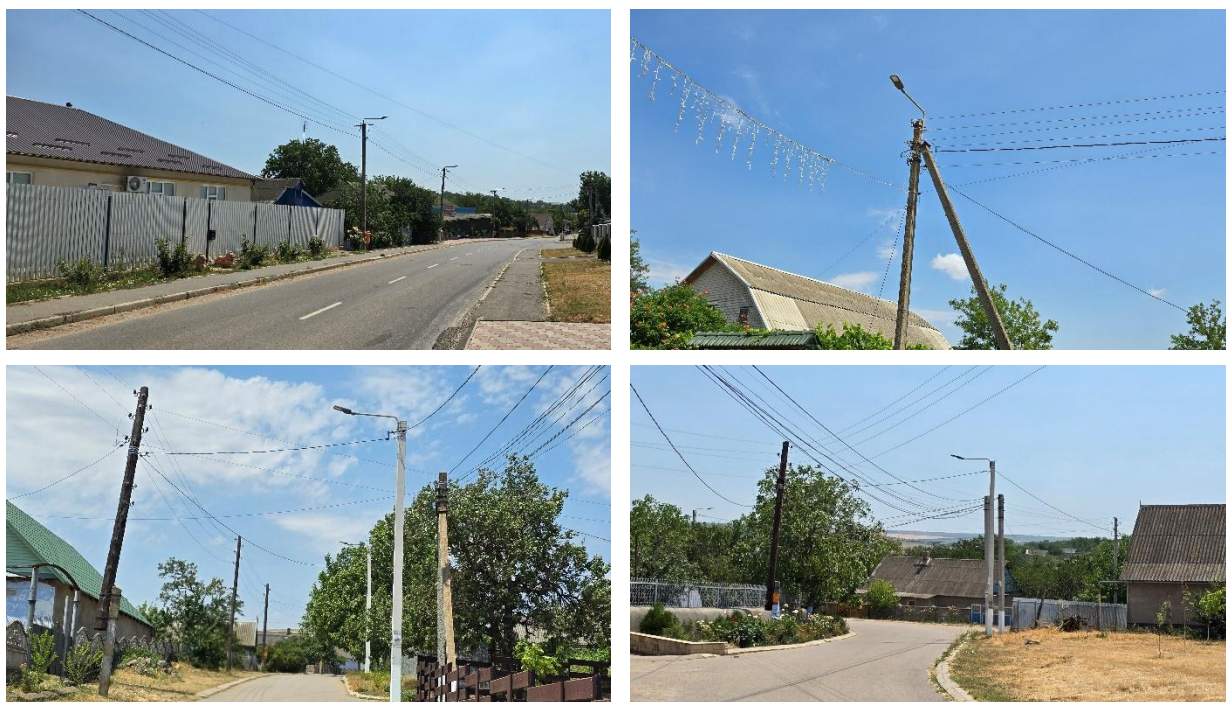
Figura 3. Iluminat public cu corpuri de iluminat LED în s. Feștețița
