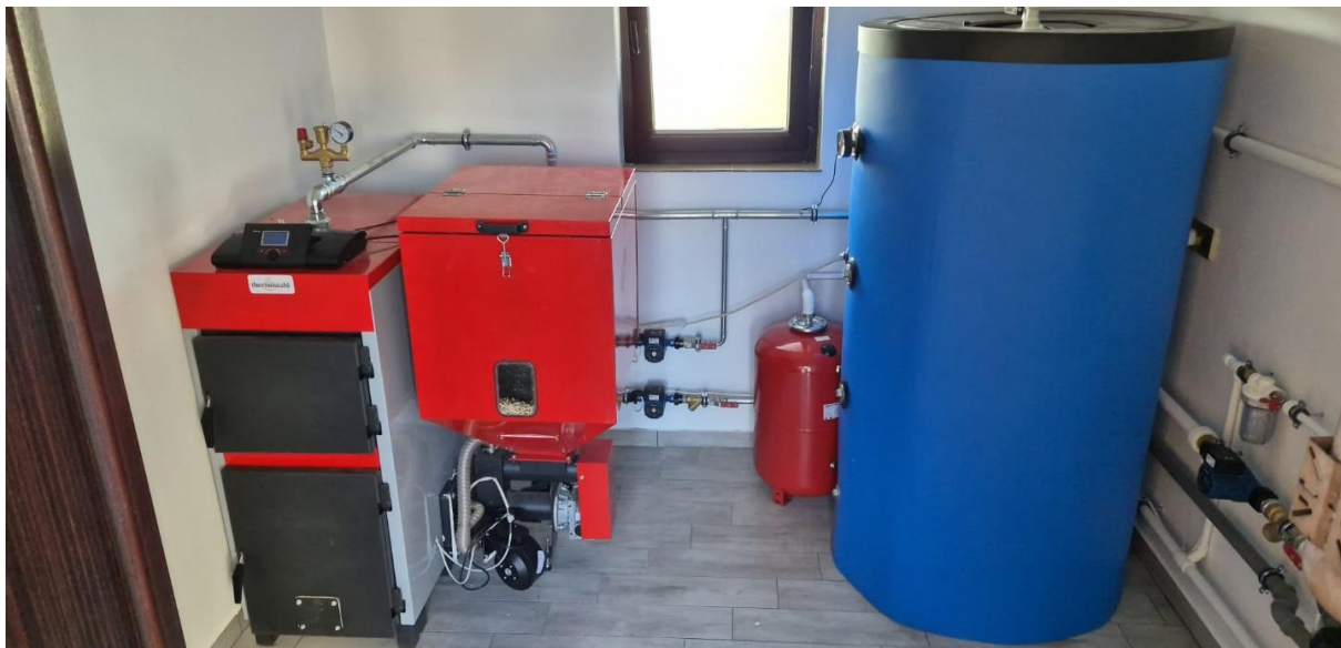
Рисунок 6.6. Приклад улаштування біопаливної системи опалення садибного будинку
