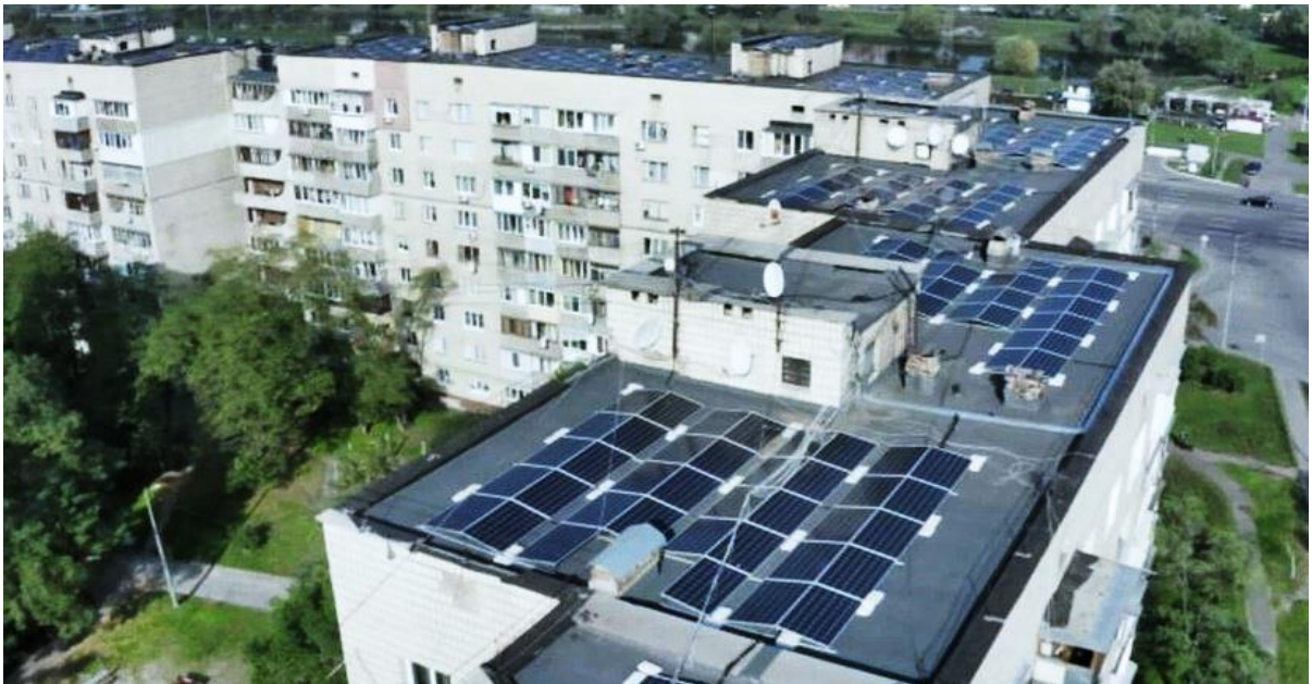
Рисунок 6.7. Приклад дахової СЕС на багатоквартирному будинку
