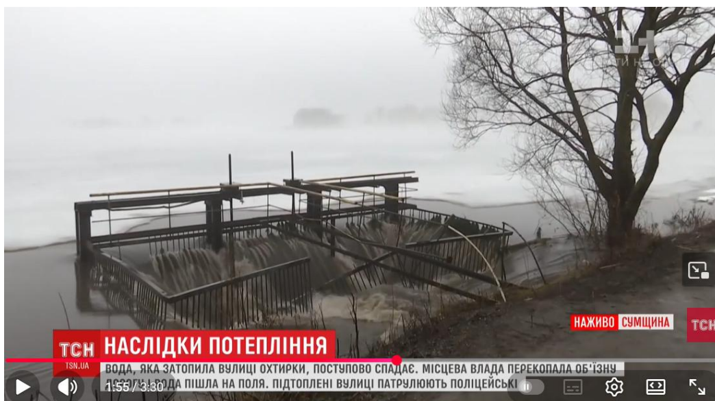
Рис.А2.38. Гідроспоруди на р. Охтирка біля м. Охтирка
