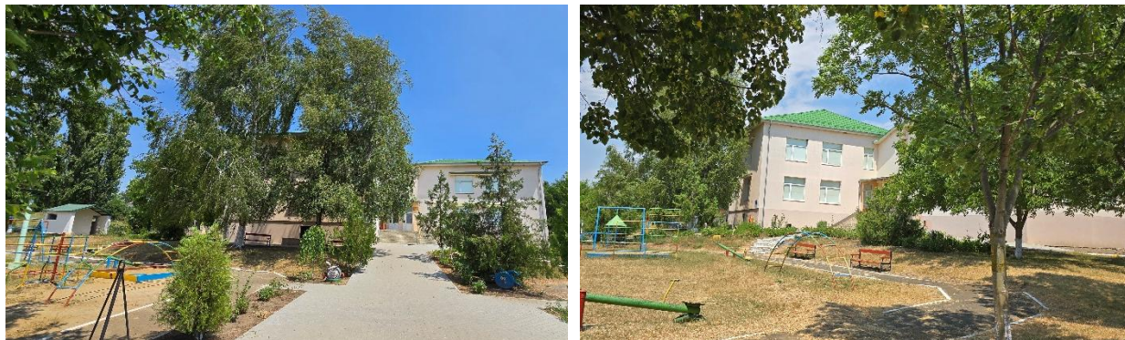
Figura 5. Grădinița de copii „Voinicel”
