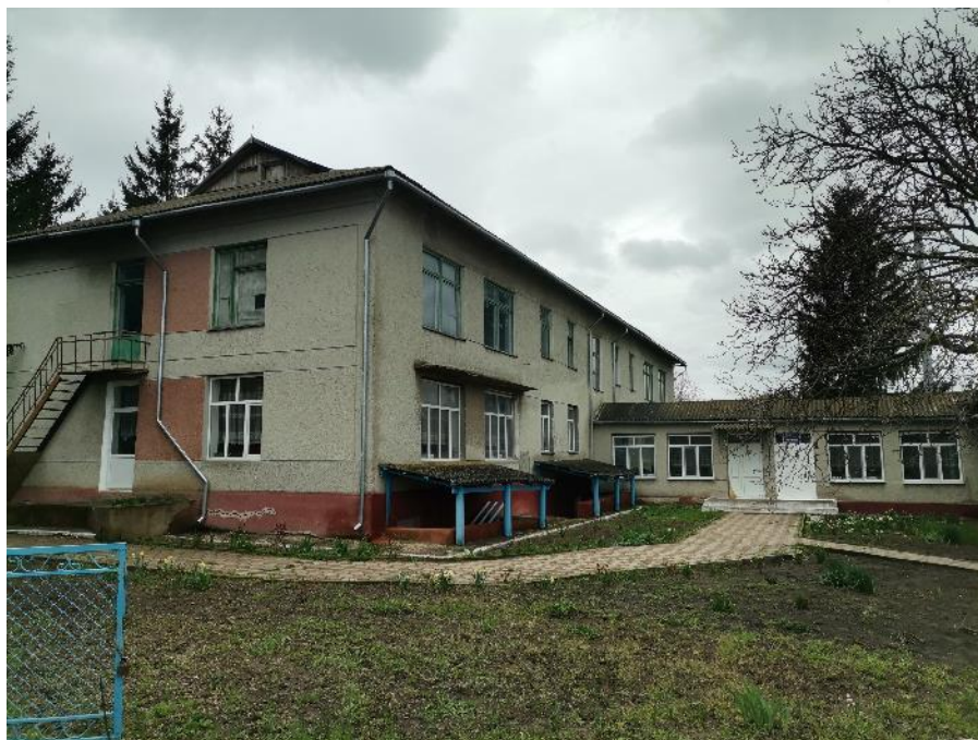
Figure 19 Clădirea Grădinița din Țareuca
