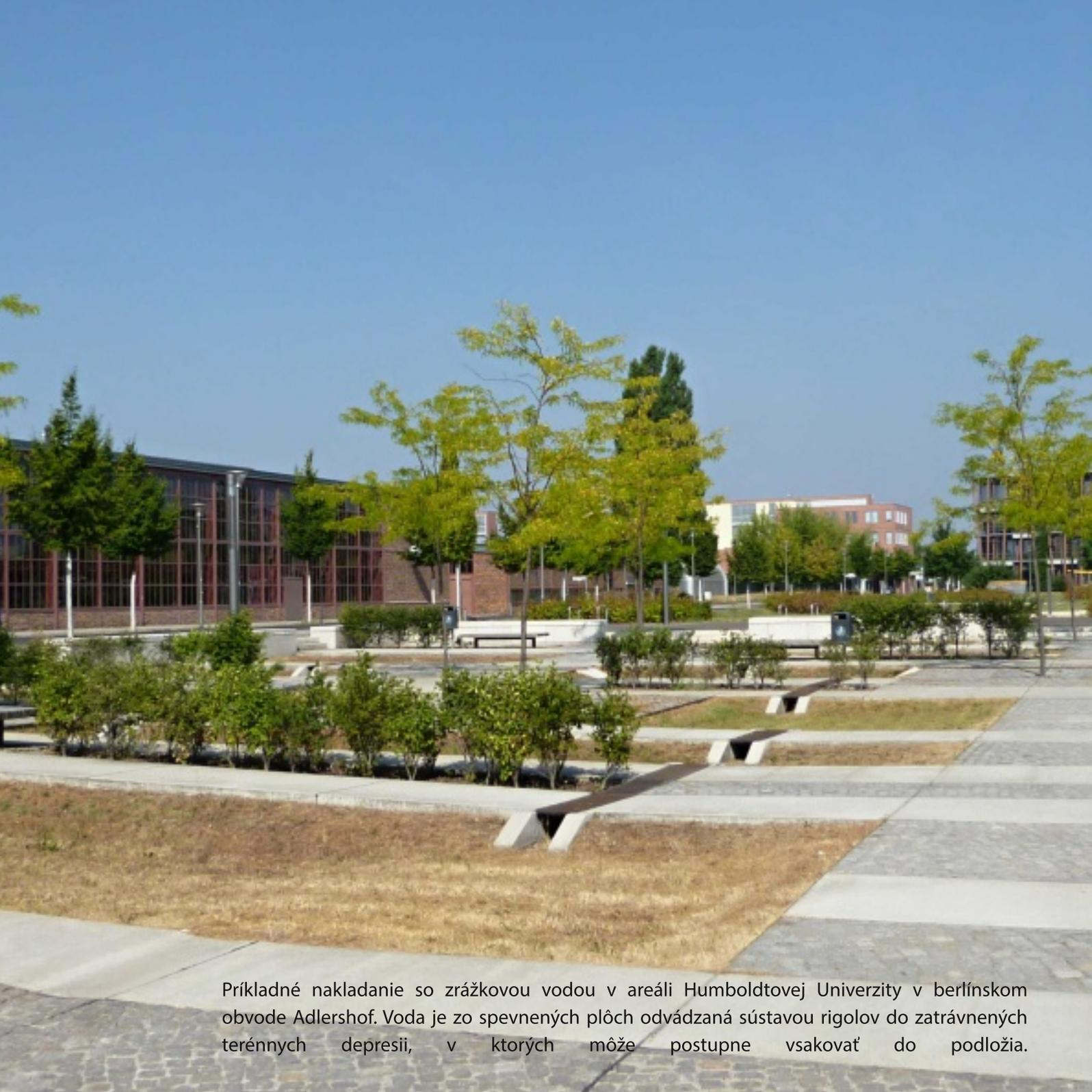
Príkladné nakladanie so zrážkovou vodou v areáli Humboldtovej Univerzity v berlínskom obvode Adlershof. Voda je zo spevnených plôch odvádzaná sústavou rigolov do zatravnených terénnych depresii, v ktorých môže postupne vsakovať do podložia.
