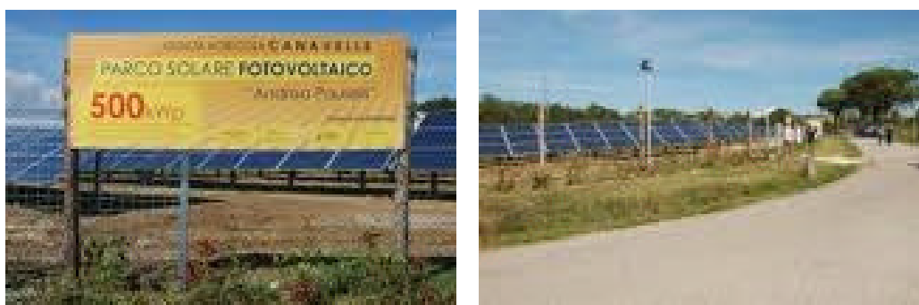
Figura n. 5 - Impianto di Canavelle nel comune di Umbertide
