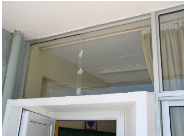
Εικόνα 5.10: Κουφώματα κτιρίου Γυμνασίου
