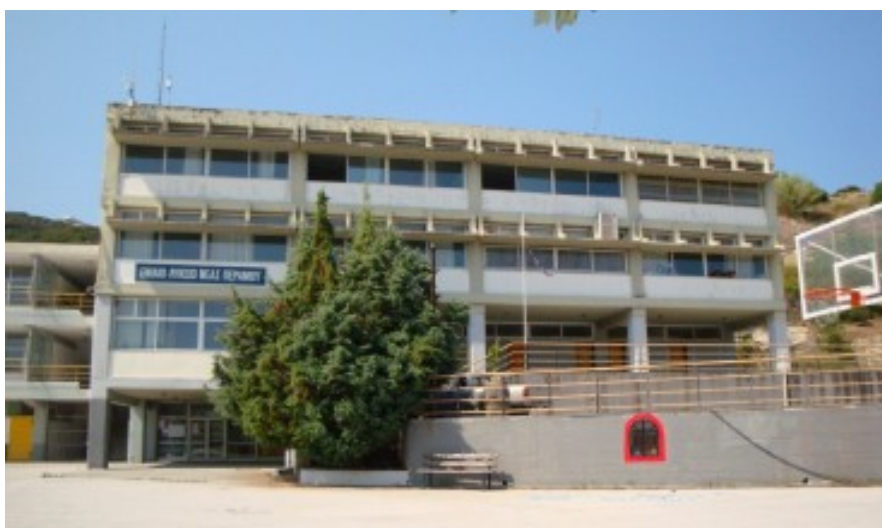
Εικόνα 5.9: Νότια όψη κτιρίου Λυκείου Νέας Περάμου
