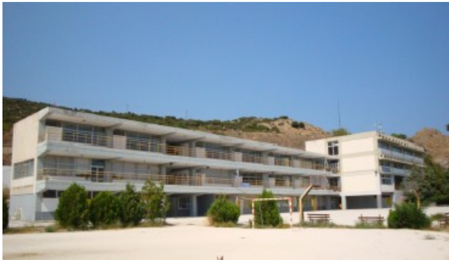
Εικόνα 5.8: Νότια και δυτική όψη κτιρίου Γυμνασίου Νέας Περάμου
