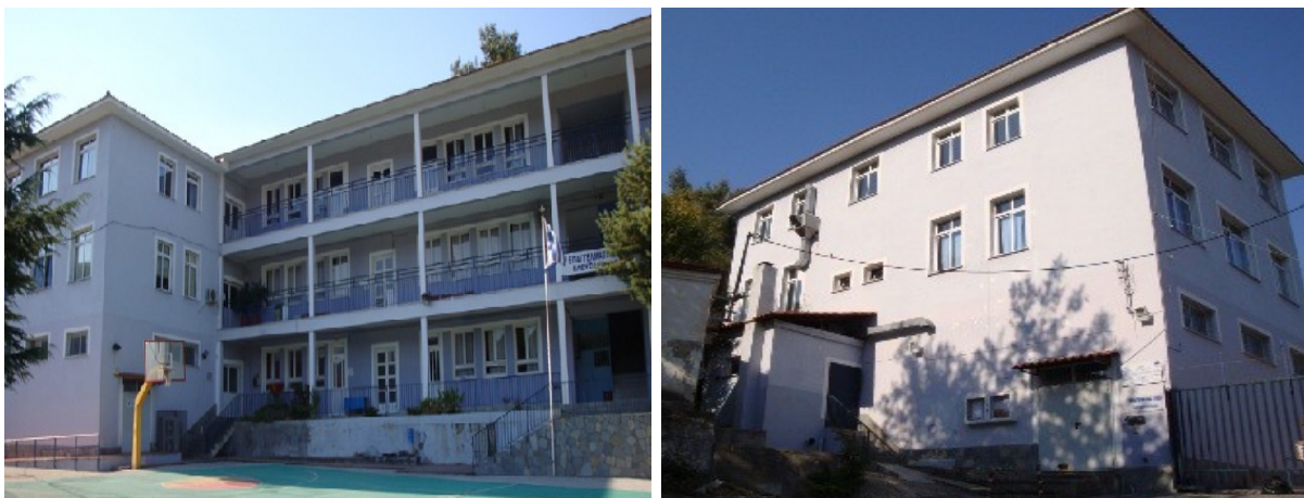
Εικόνα 5.5: Κύρια και νότια όψη κτιρίου ΕΠΑΛ Ελευθερούπολης
