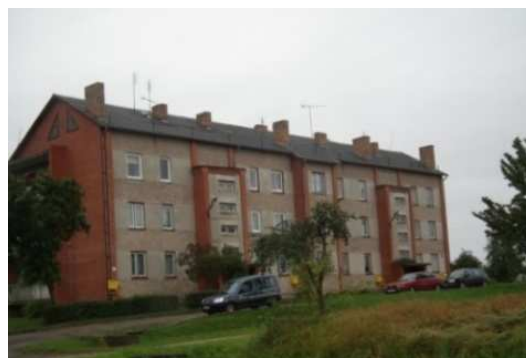
1.30.b.att. Daudzdzīvokļu ēka Ezerē
