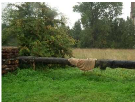
1.15.a. att. Vecā tipa siltumtrase Rubas ciemā
