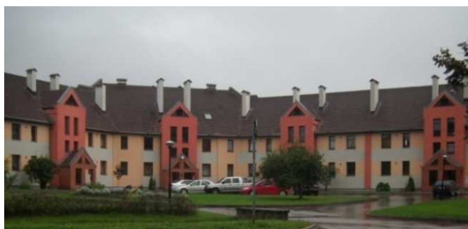
1.28.a.att. Renovēta daudzdzīvokļu ēka Saldus pilsētā
