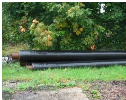
1.15.b. att. Jaunā tipa siltumtrašu cauruļvadi Saldus pilsētā
