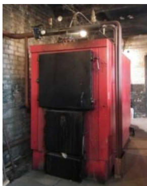
1.12.a. att. Malkas katls Rubas ciema katlu mājā
