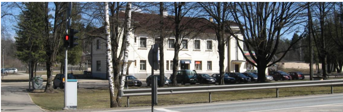
16. att. Autostāvvietā pie dzelzceļa stacijas Ķegumā
