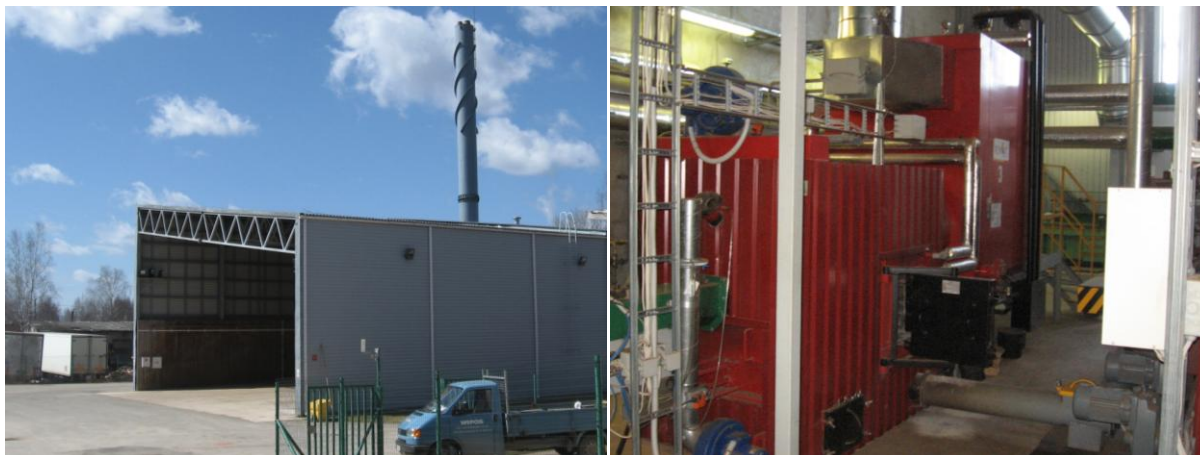
5. att. Šķeldas katlu māja Ķegumā
