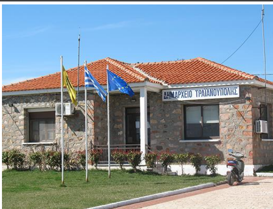
Ενδεικτική φωτογραφία τμήματος όψης κτιρίου
