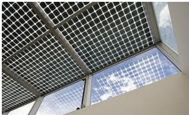
Σχήμα 8-11. Ενσωματωμένα φωτοβολταϊκά πλαίσια (BIPV)
