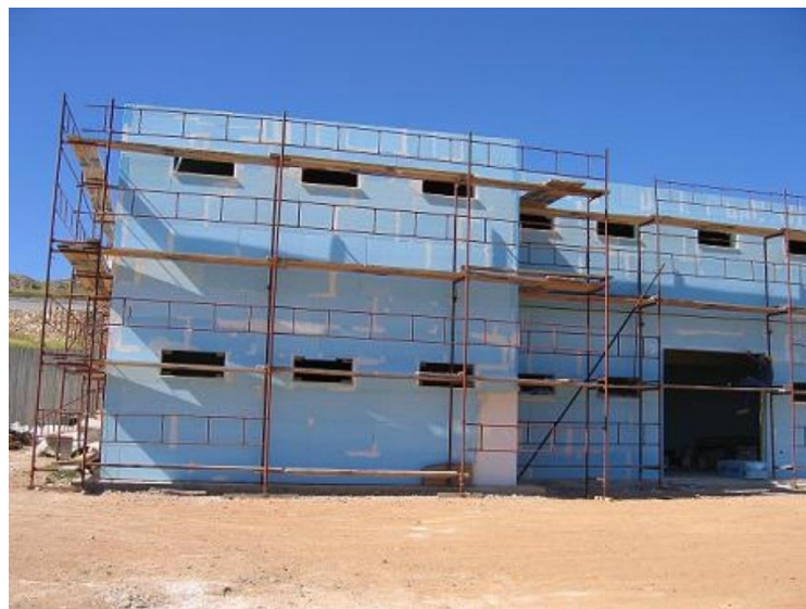
Σχήμα 8-4. Κατασκευή θερμοκέφαλους σε κτίριο.
