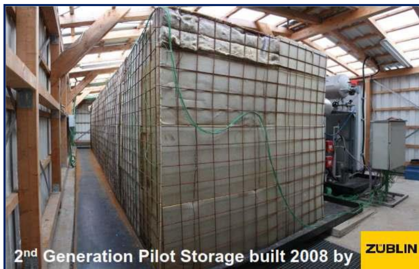
Σχήμα 8-16. Διάταξη αποθήκευσης θερμότητας με βάση το τσιμέντο
