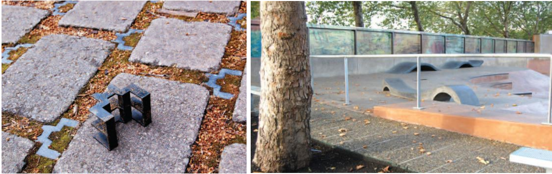
Σχήμα 8-23. Εφαρμογή διαπερατών υλικών σε διάφορες κοινόχρηστες επιφάνειες
