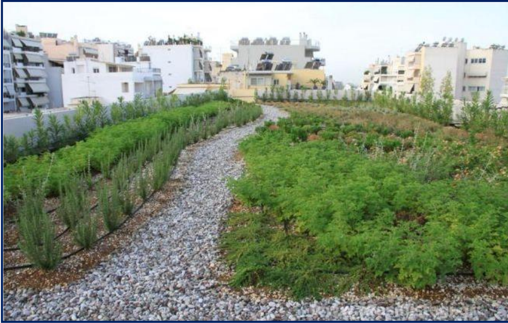
Σχήμα 8-20. Παράδειγμα πράσινης στέγης, 2 ο και 11 ο Δημοτικό σχολείο Νέας Σμύρνης,
