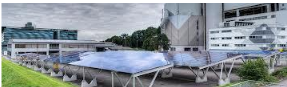
Σχήμα 8-22. Παράδειγμα χρήσεως φωτοβολταϊκών για τεχνητό σκιασμό και βραδινό φωτισμό χώρων στάθμευσης
