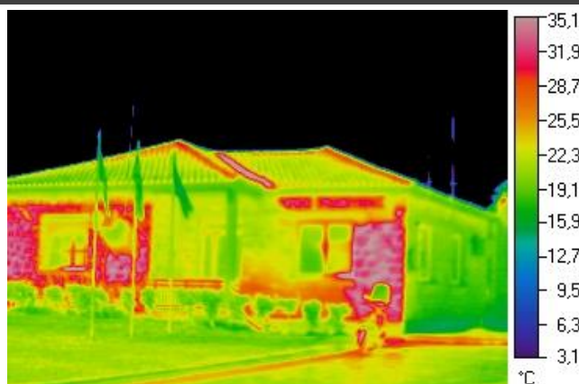
Θερμική εικόνα τμήματος όψης κτιρίου
