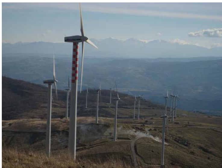
Fig. 5.17 – Vista di una parte del parco eolico di Montemurro.
