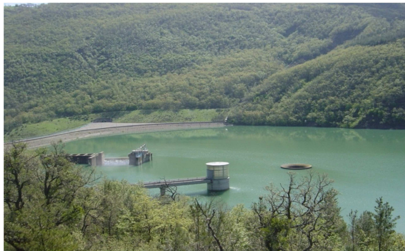
Figura 4.1. Diga di Ponte Fontanelle sul Torrente Camastra - Trivigno (Pz)
