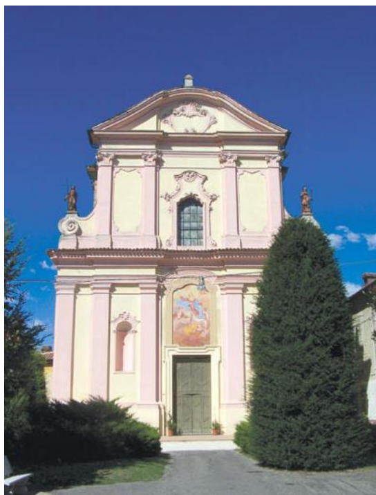
Figura 100. Chiesa Correggioverde. Fonte: COMUNE DI DOSOLO, www.comune.dosolo.mn.it/servizi/informazioni/informazioni_fase03.aspx?ID=125
