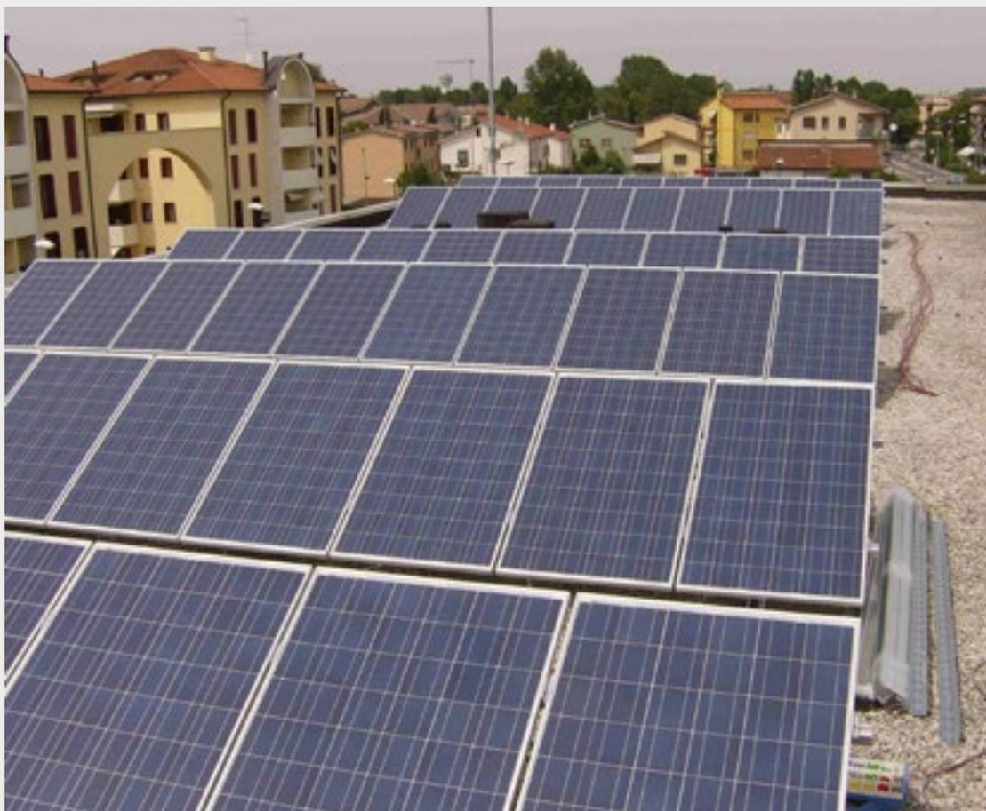
*Impianto fotovoltaico da 13kW<sub>p</sub> installato presso la sede della Municipalità di Marghera*
