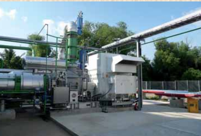
Geothermiekraftwerk in Landau
