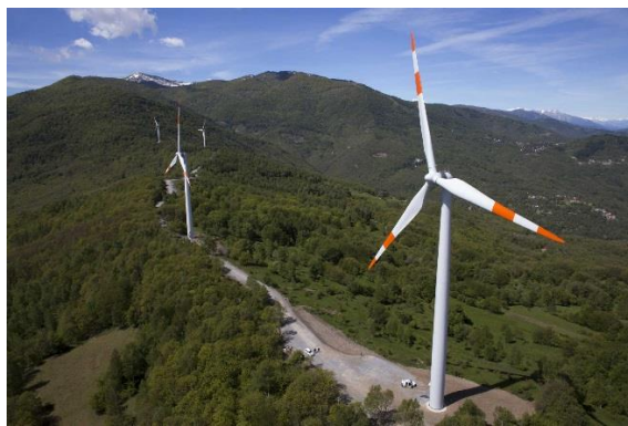
Parco eolico sul colle San Giacomo (Viola-Priola)
