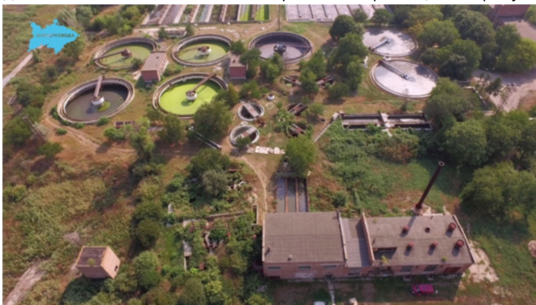
Рис. 5. Водоочисні споруди м. Біла Церква. Джерело: ТОВ Білоцерківвода .
