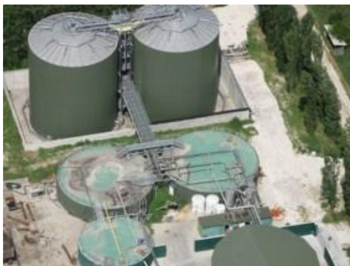
Fig. 37 Impianto di digestione anaerobica SESA (Fonte. http://www.sesaeste.it/ ).
