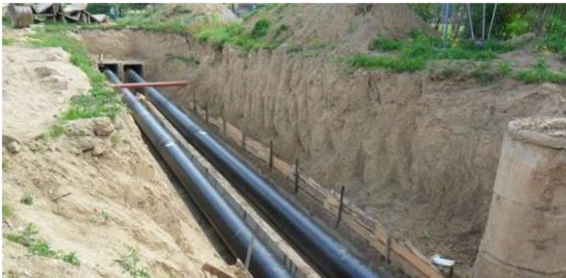
Малюнок 10. Без канальна прокладка тепломереж
