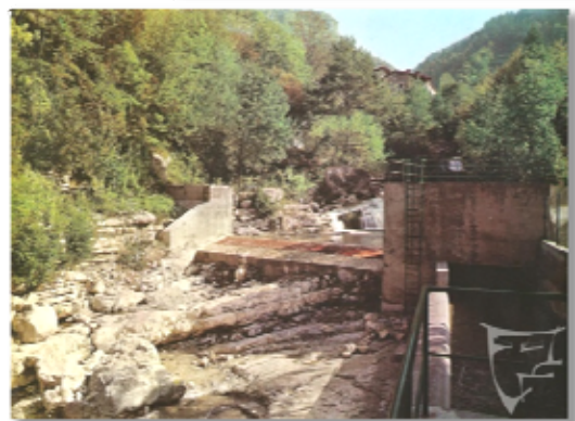
Figura 29: Presa sul rio Cavallo
