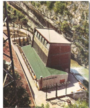
Figura 27: Centrale di San Colombano
