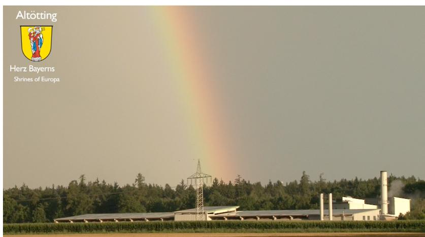
*Das Biomasseheizkraftwerk Am Huberstadl 1 liefert jährlich 8 Mio kWh Stunden Strom, erzeugt durch Hackschnitzel aus der Region. Der Anteil an der Wärmeversorgung für die Stadt Altötting beträgt 20 %. Bei weiterer Optimierung des Wärmenetzes könnte das*
