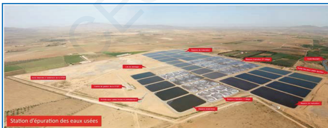
Figure 31 – Station d'épuration des eaux usées
