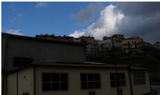
Fig 5.4.2.1 Fotografia dell'impianto Fotovoltaico sulla Palestra comunale
