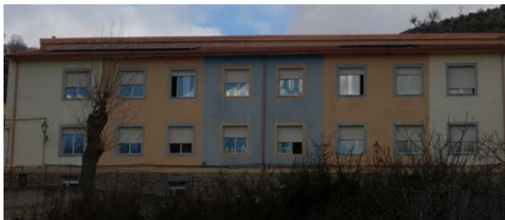
Fig 5.4.2.4 Fotografia dell'impianto Fotovoltaico sulla Scuola elementare
