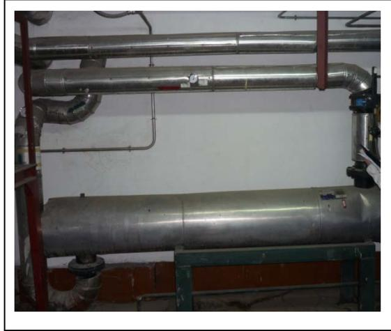
La UTE propone la instalación de un intercambiador de placas corrugadas de acero inoxidable Aisi 316, placas desmontables para facilitar su limpieza y sustitución, y presión máxima de trabajo 10 bar, en sustitución del tubular existente, lo que generará un incremento del rendimiento, una menor pérdida de carga y mayor facilidad en las tareas de mantenimiento.
