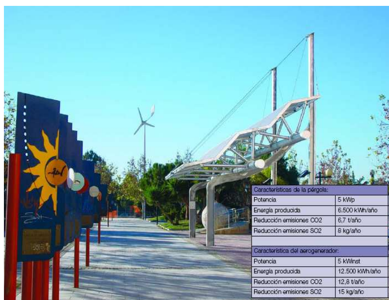
Figura 37: Pérgola fotovoltaica instalados en la Plaza de la Ciencia (Murcia).
