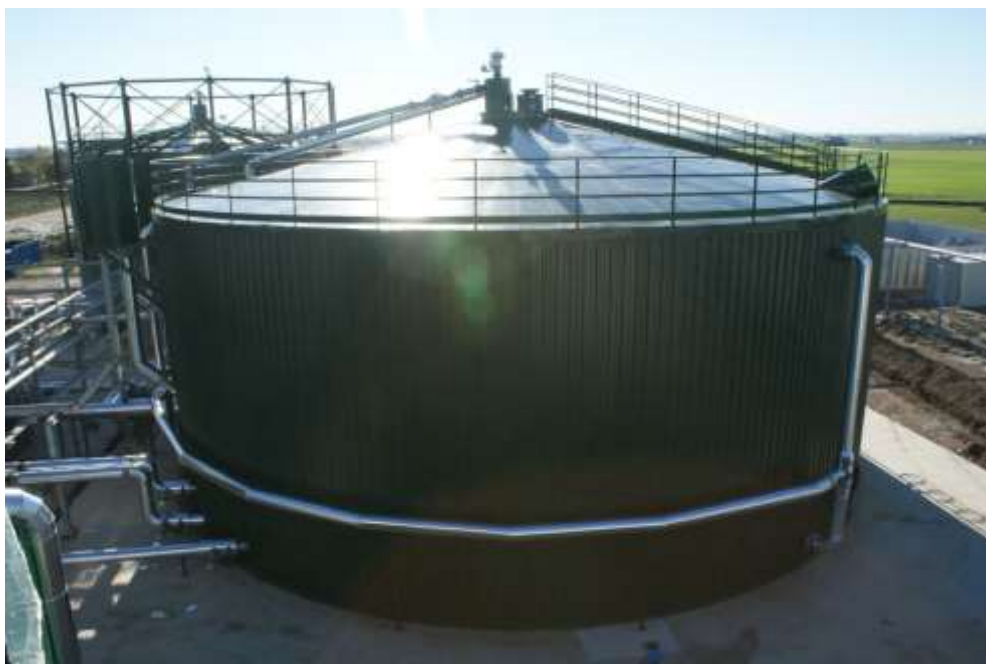
Figura 93 Impianto a biogas Società Agricola Pascolone, 2012
