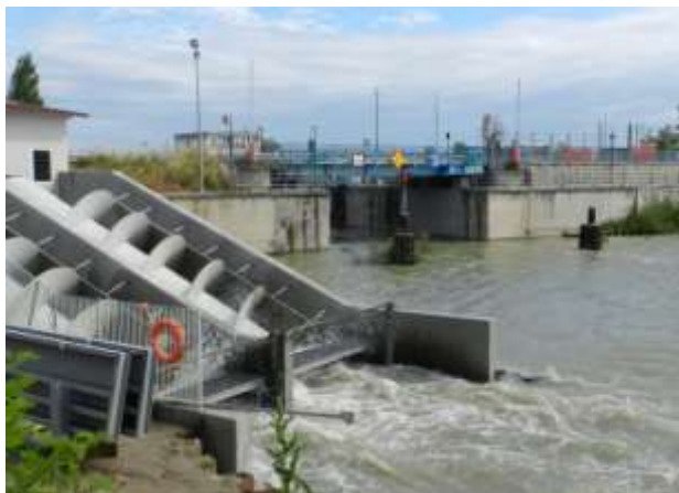
Figura 94 Impianto idroelettrico di Valpagliaro – Fonte: La Nuova Ferrara
