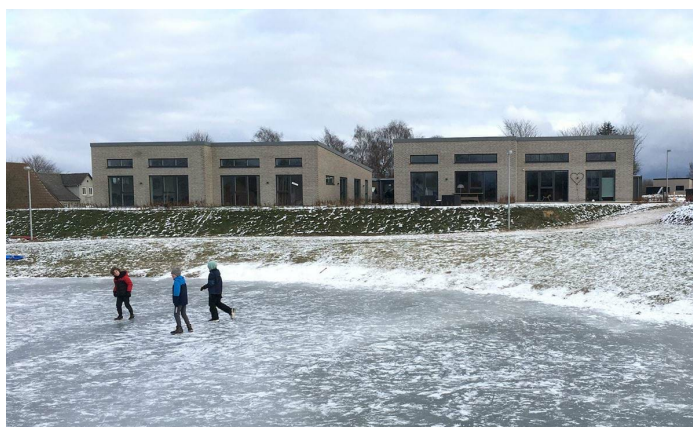
Regnvandsbassin ved nybyggeri
