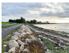
Foto fra den nyanlagte cykelsti til Vrinnens langs Kalø Vig. Cykelstien vil kunne hæves gradvist over de næste 30-100 år, alt efter behovet for, at beskytte de bagvedliggende værdier for det stigende havvand.
