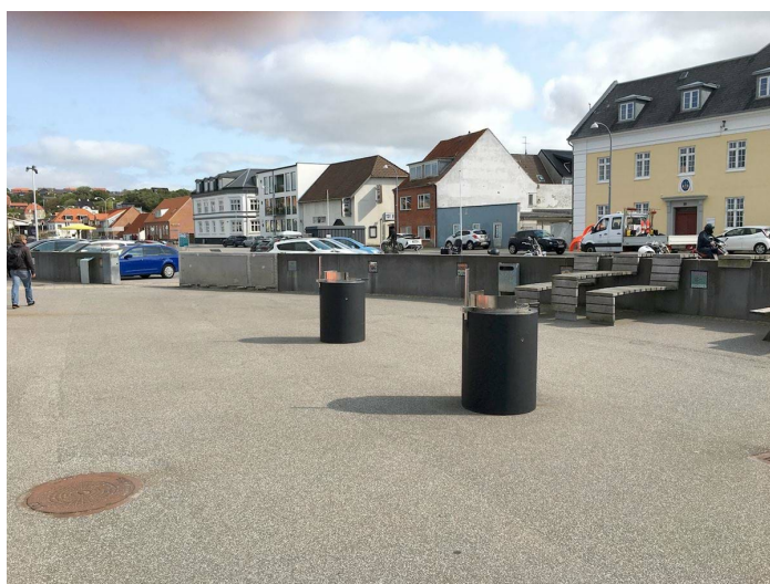
Muren i Lemvig
