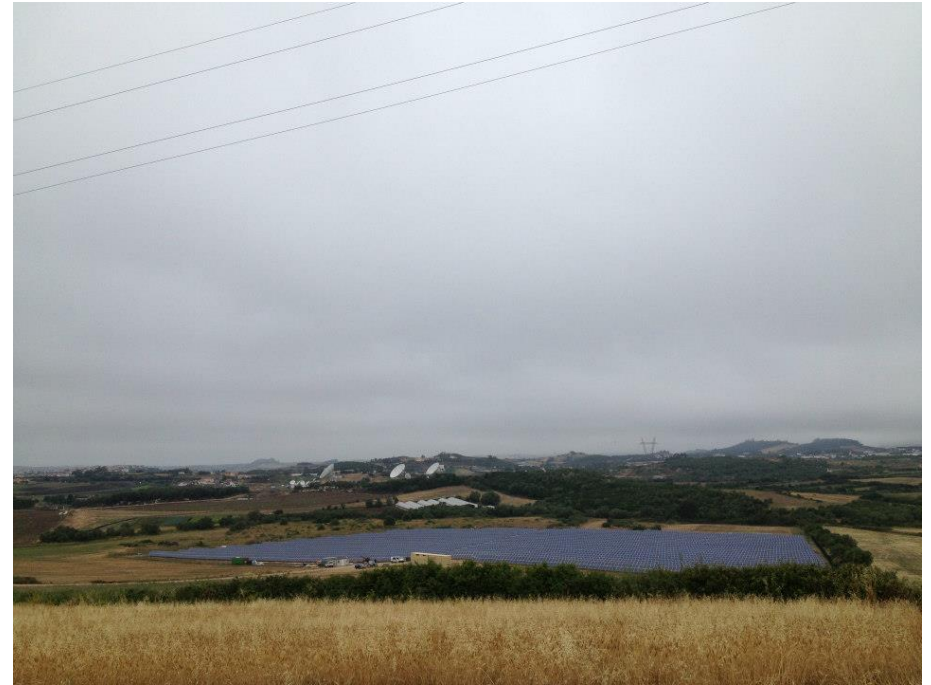
© RENTeci Lda - parque fotovoltaico de Alfouvar
