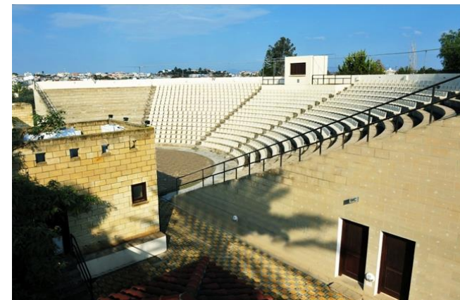
Εικόνα 1 Δημοτικό Αμφιθέατρο Δήμου Λακατάμιας
