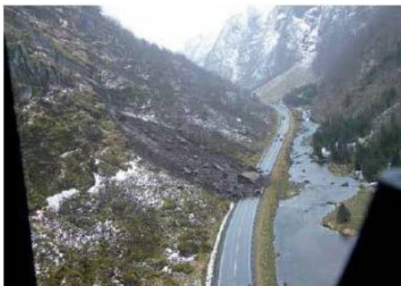
ΕΙΚΟΝΑ 6.3: Κατολισθήσεις βράχων, σε οδικό τμήμα της Νορβηγίας
