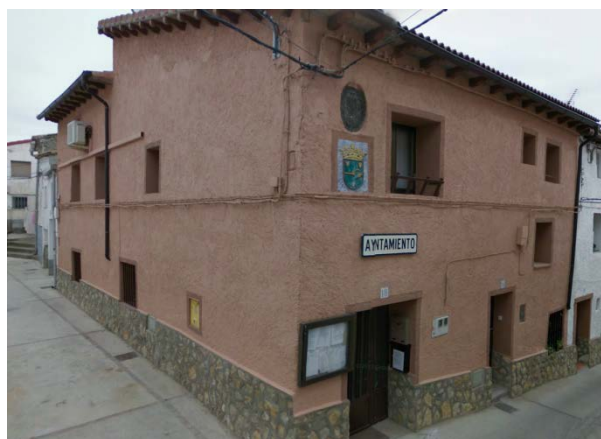
Figura 3: Imagen del municipio de Aladrén y del Ayuntamiento
