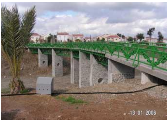
Εικόνα 19 Πεζογέφυρα στον Πεδιαίο Ποταμό
