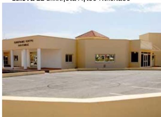
Εικόνα 24 Πολυδύναμο κέντρο Λακατάμιας
