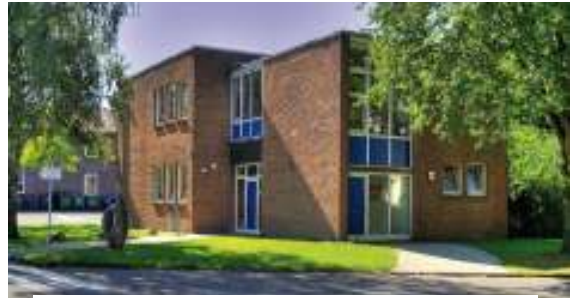
Die Volkening-Schule vor der Sanierung (Foto: e&u energiebüro gmbh, Bielefeld)
