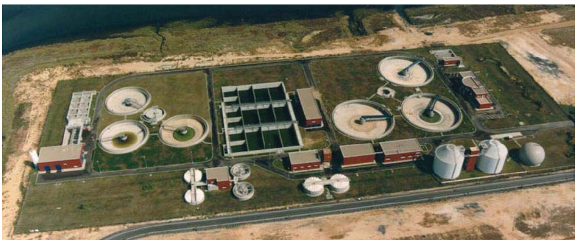
Vista general de la depuradora de Huelva Fuente: Documento "El agua en Huelva"
