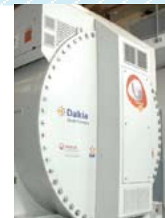
Pile à hydrogène 15 e arrondissement.
