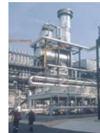
Compagnie parisienne de chauffage urbain à Vitry.
