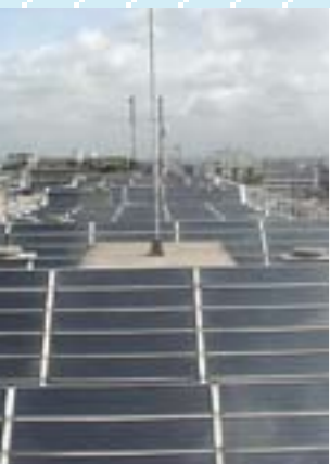
Panneaux solaire sur immeuble de l'OPAC rue de Plantes 14 e arrondissement.
