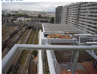
Toiture végétalisée et panneaux photovoltaïques
