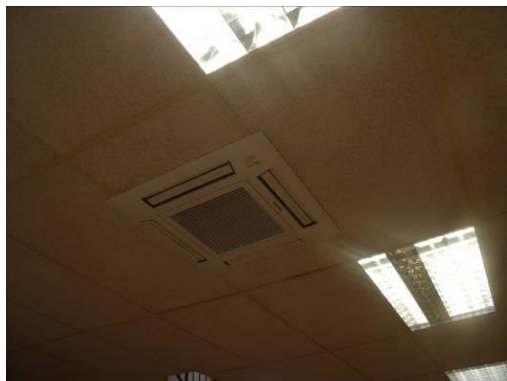
Figura 5. Unitats terminals tipus split
