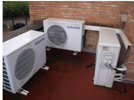
Figura 4. Generador de calor
