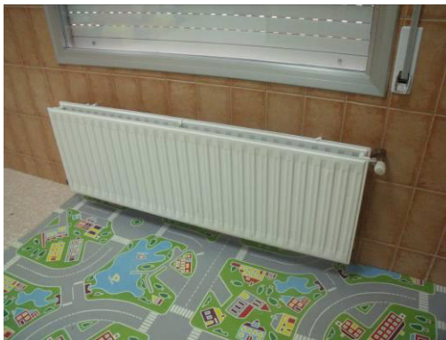
Figura 3. Unitats terminals de calefacció
