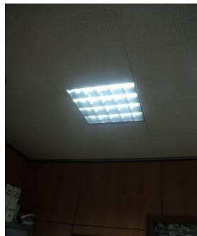
Figura 7. Detall enllumenat despatx
