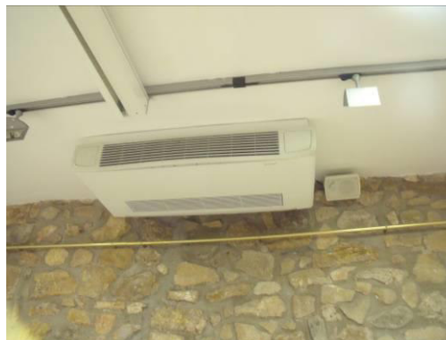
Figura 4. Unitats terminals de calefacció
