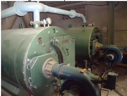
Figura 9. Generador de calor
