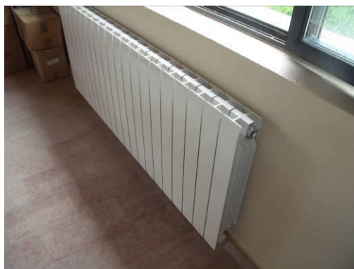
Figura 4. Unitats terminals de calefacció
