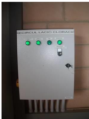
Figura 12. Quadre de control
