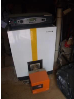
Figura 3. Generador de calor integrat
