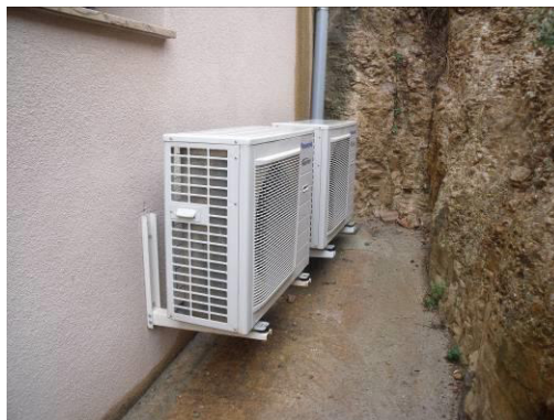
Figura 6. Generador de fred i calor
