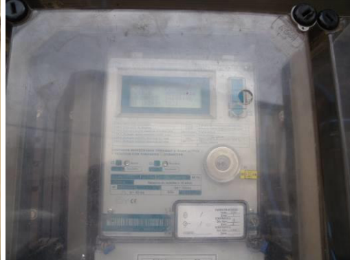
Figura 6. Comptador elèctric bomba pou
