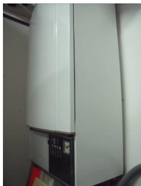
Figura 3. Generador de calor
