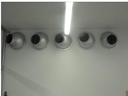
Figura 3. Unitats terminals conductes
