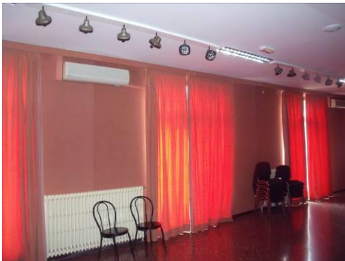
Figura 3. Unitats terminals de calefacció
