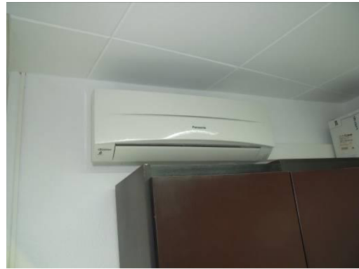
Figura 4. Unitat terminal bomba de calor
