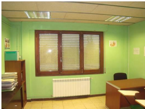
Figura 5. Unitats terminals de calefacció
