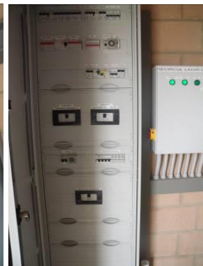
Figura 14. Quadre de control
