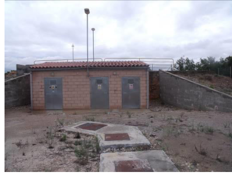
Figura 4. Façana principal dipòsit la Cometa
