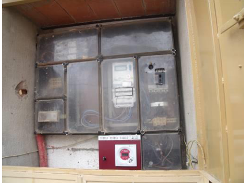
Figura 5. Quadre elèctric pou
