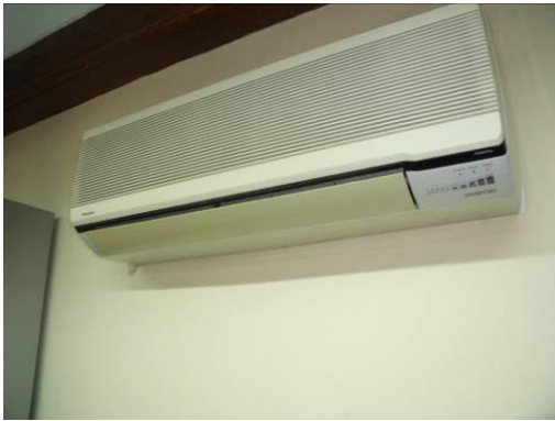
Figura 3. Unitat terminal bomba de calor
