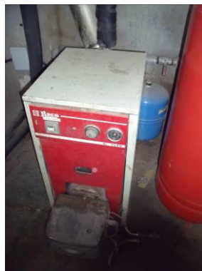
Figura 12. Caldera de gasoil ACS
