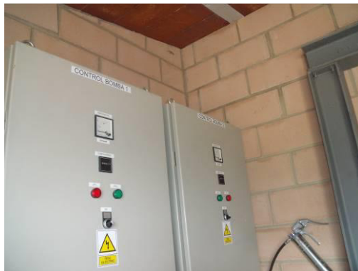
Figura 13. Quadre de control
