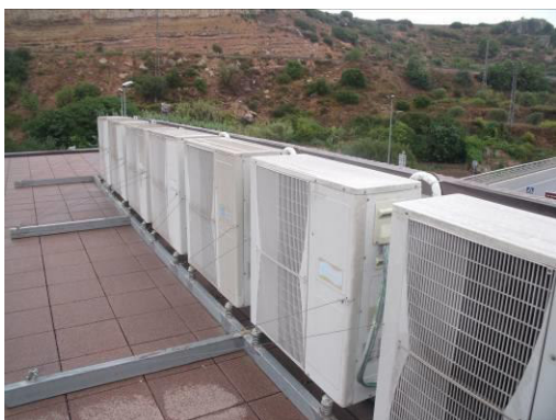
Figura 5. Unitats exteriors bomba de calor
