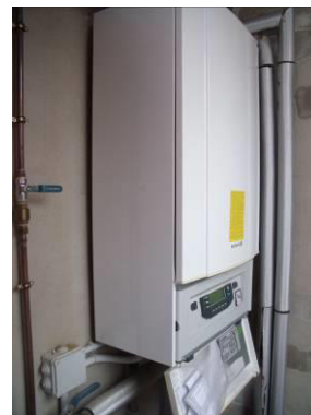
Figura 6. Generador de calor
