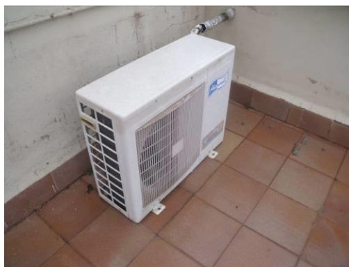
Figura 6. Unitats exteriors bomba de calor
