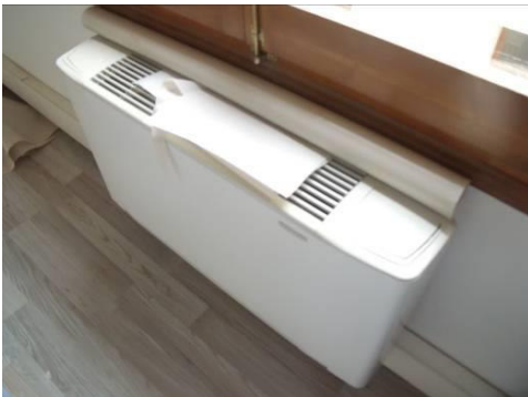
Figura 6. Unitats terminals de climatització
