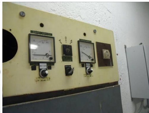
Figura 9. Quadre de control
