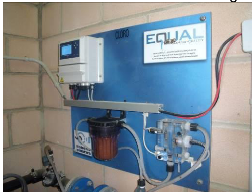
Figura 19. Sistema de cloració
