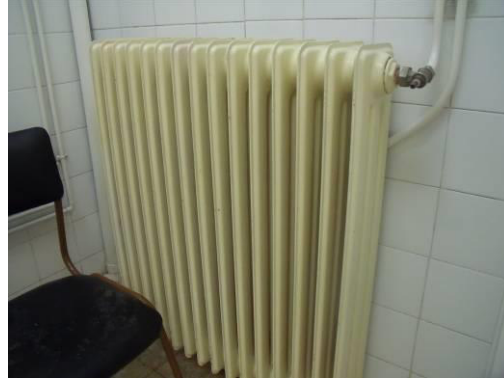
4. Unitat terminal radiador
