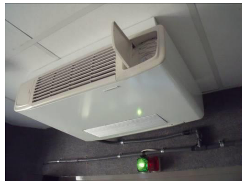
Figura 7. Unitats terminals de climatització
