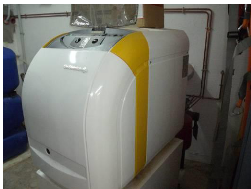
Figura 3. Generador de calor
