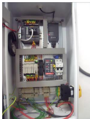
Figura 8. Quadre de control
