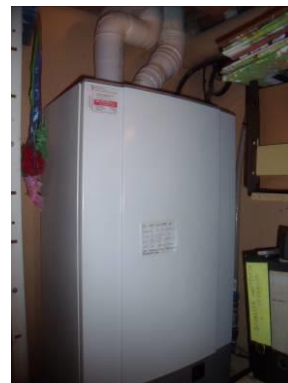
Figura 4. Generador de calor
