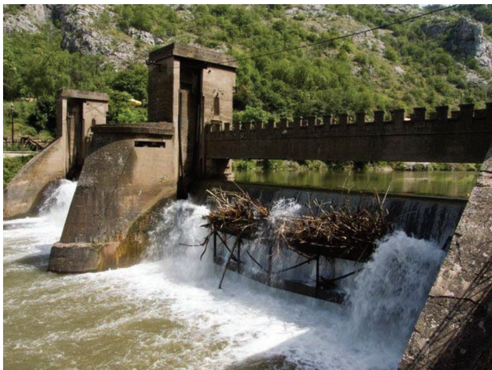
Слика 3.4. Поглед на брану хидроелектране „Сићево“
