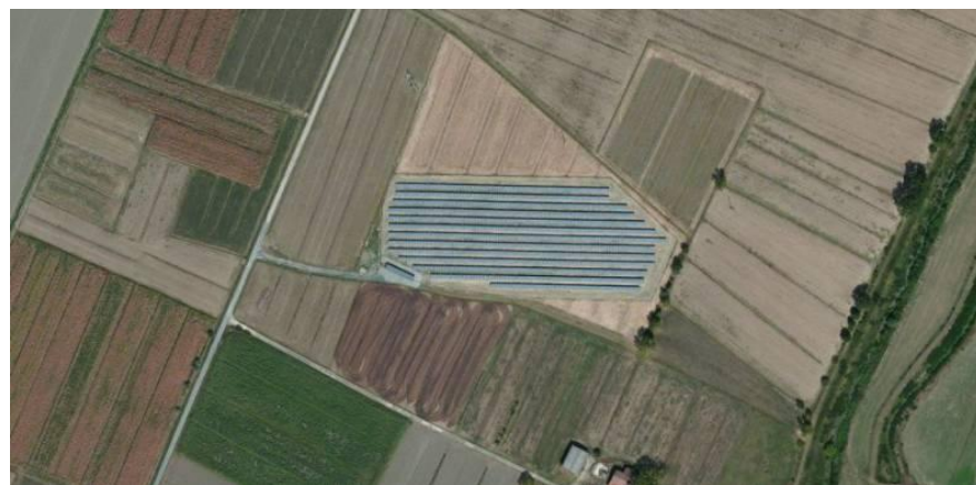
Figura 17: Parco fotovoltaico a terra a San Secondo Parmense
