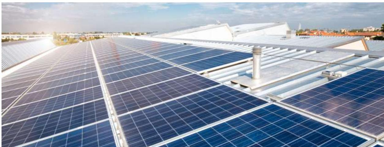
Figura 29: Impianto fotovoltaico sulla copertura del nuovo polo scolastico da 121 kWp
