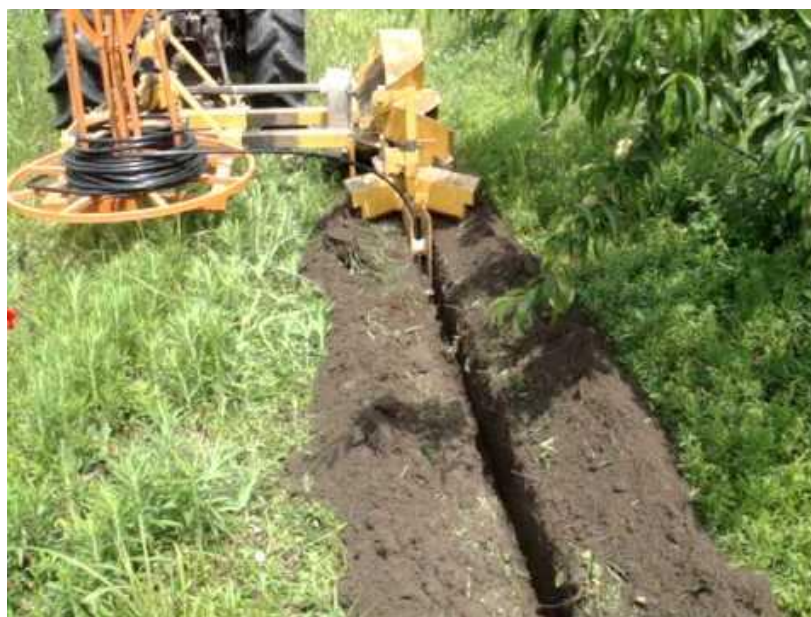
Τοποθέτηση υπόγειων σωληνώσεων
