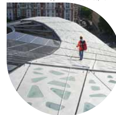
Stade Jean Bouin, panneaux solaires, 16 e
