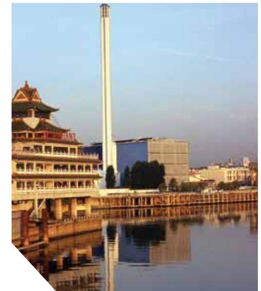
Usine de production de chaleur, Ivry-sur-Seine
