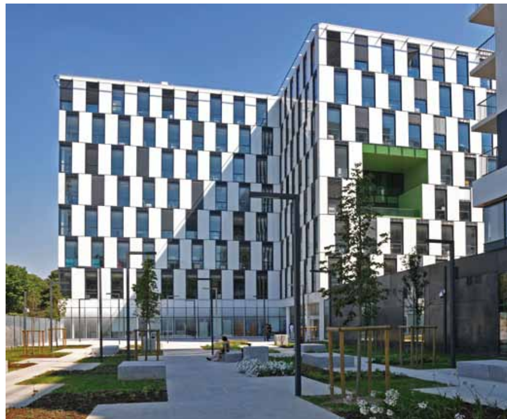
Immeubles de bureaux, 19 e
