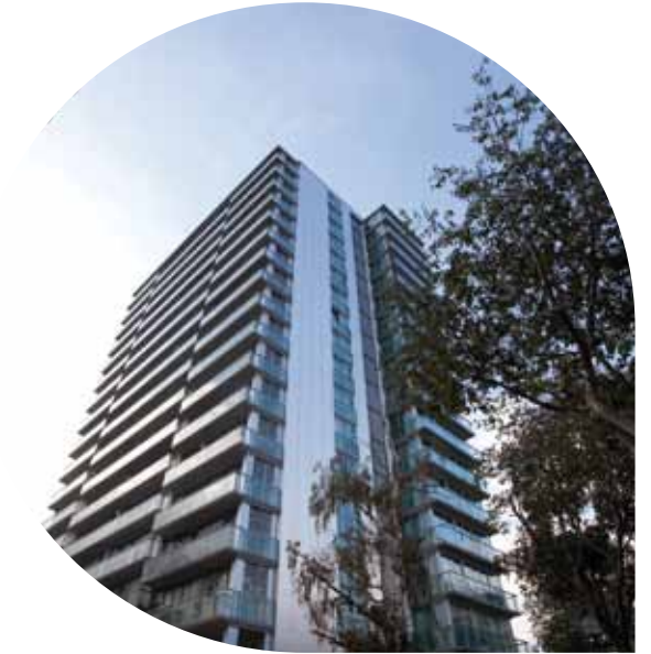
Tour Bois-le-Prêtre, 17 e
