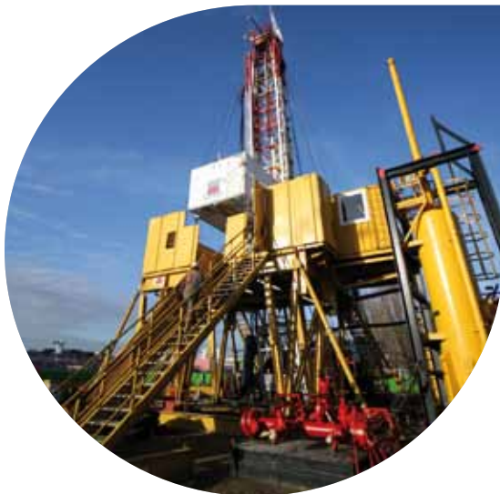
Puits de géothermie, 19 e
